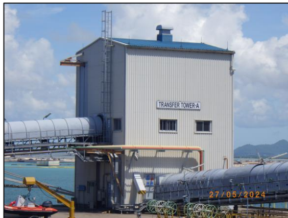
รูปที่ 2-8 อาคาร Transfer Tower เป็นระบบปิด บริเวณท่าเทียบเรือของโครงการฯ
