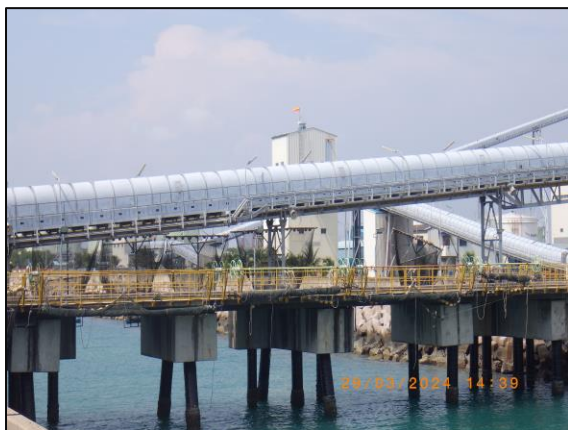
รูปที่ 2-5 การปิดคลุมสายพานลำเลียงถ่านหินบริเวณท่าเทียบเรือ ยกเว้นสายพานบริเวณหน้าท่า
