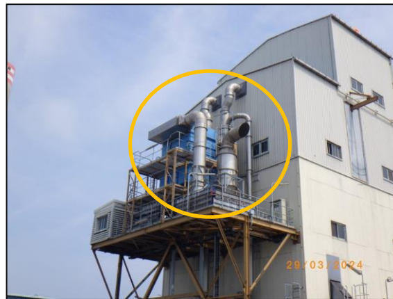
รูปที่ 2-10 ระบบ Dust Prevention Hood ที่ติดตั้งบริเวณอาคาร Transfer Tower
