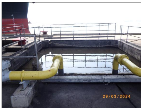
รูปที่ 2-14 ป่อรวบรวมน้ำจากกิจกรรมของท่าเรือขนถ่ายถ่านหิน
