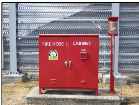
รูปที่ 2-12 ตู้เก็บสายดับเพลิง (Fire Hose Cabinet and Hydrant Valve) บริเวณลานกองถ่านหิน
