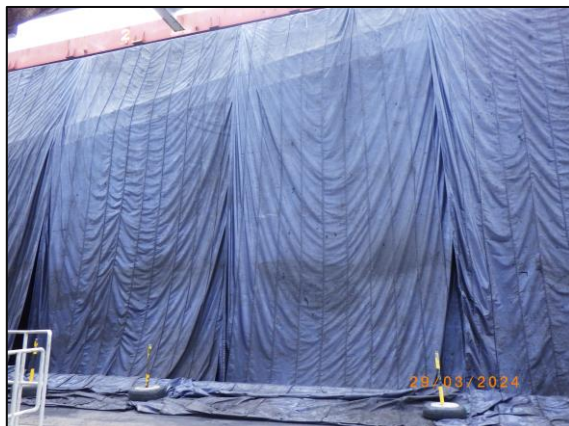
รูปที่ 2-6 การติดตั้งผ้าใบขณะมีกิจกรรมขนถ่ายถ่านหิน
