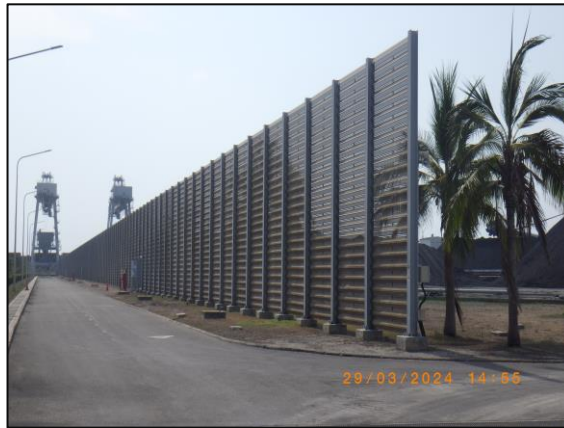
รูปที่ 2-7 กำแพงเบี่ยงเบนทิศทางลมสูง 6 เมตร บริเวณทิศใต้ของลานกองถ่านหิน
