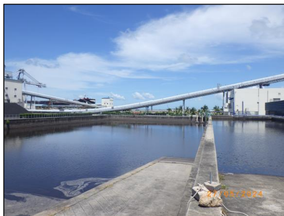
รูปที่ 2-15 ป่อกักตะกอนบริเวณลานกองถ่านหินของโครงการฯ
