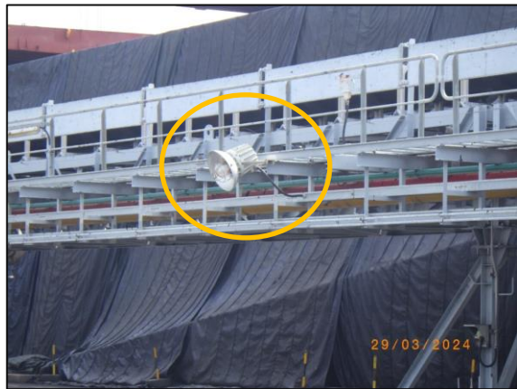
รูปที่ 2-28 การติดตั้งไฟส่องสว่างตลอดสายพานลำเลียงถ่านหิน และบริเวณท่าเทียบเรือ
