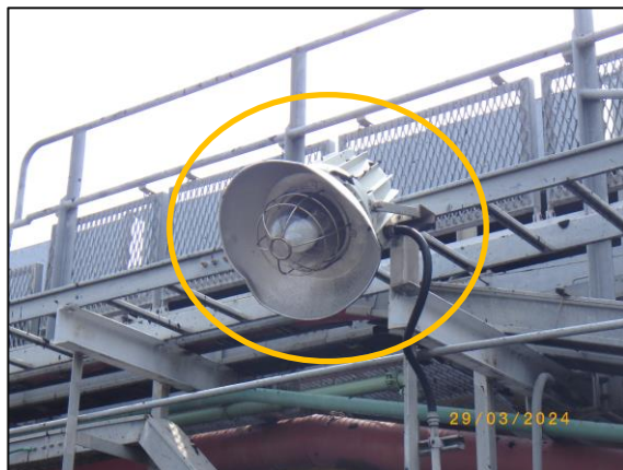
รูปที่ 2-28 การติดตั้งไฟส่องสว่างตลอดสายพานลำเลียงถ่านหิน และบริเวณท่าเทียบเรือ
