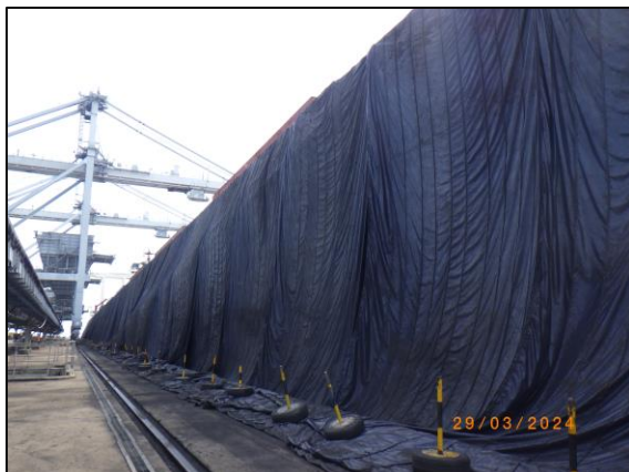
รูปที่ 2-6 การติดตั้งผ้าใบขณะมีกิจกรรมขนถ่ายถ่านหิน
