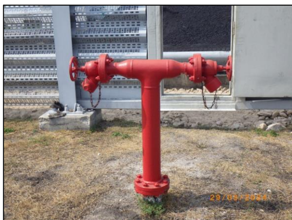
รูปที่ 2-12 ตู้เก็บสายดับเพลิง (Fire Hose Cabinet and Hydrant Valve) บริเวณลานกองถ่านหิน
